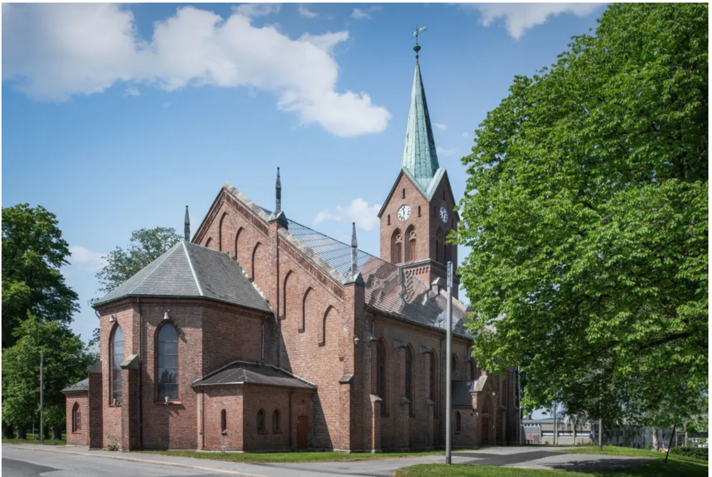
Die Kirche mit dem gebäudeintegrierten Photovoltaik-Solardachziegeln | ©SunStyle®
