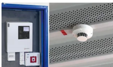
Brandmeldeanlage ©TELENOT
