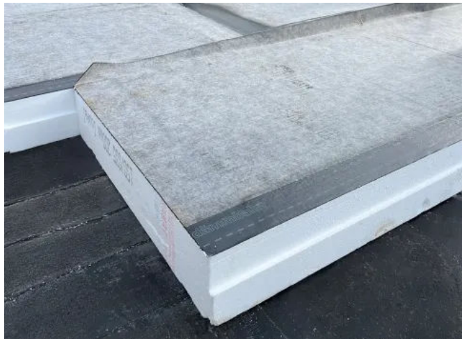
Klappbahnsystem – Verlegung von bis zu 3 m² in einem Arbeitsgang
