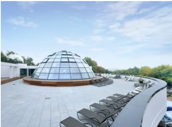
Thermazone Gefälledämmung auf genutzter Dachfläche (© STEPHAN BRENDGEN)
