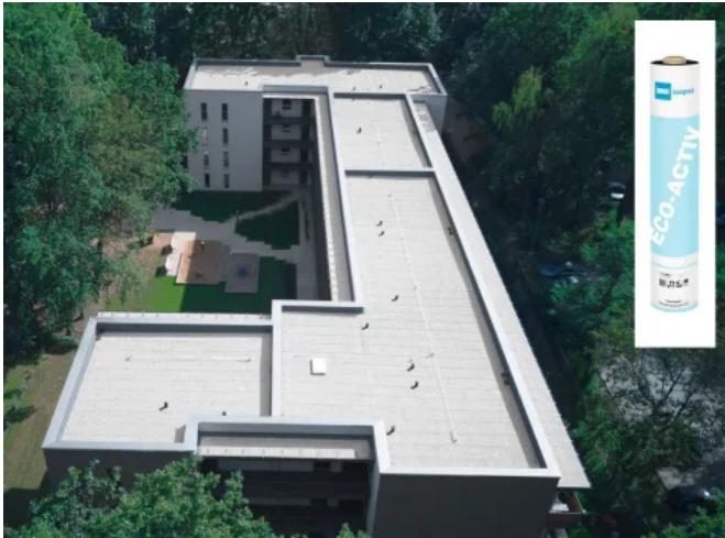
Eco-Active mit Noxite-Bestreuung – photokatalytische Oberfläche zum Stickoxid-Abbau
