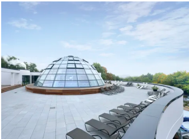
Thermazone Gefälledämmung auf genutzter Dachfläche (© STEPHAN BRENDGEN)
