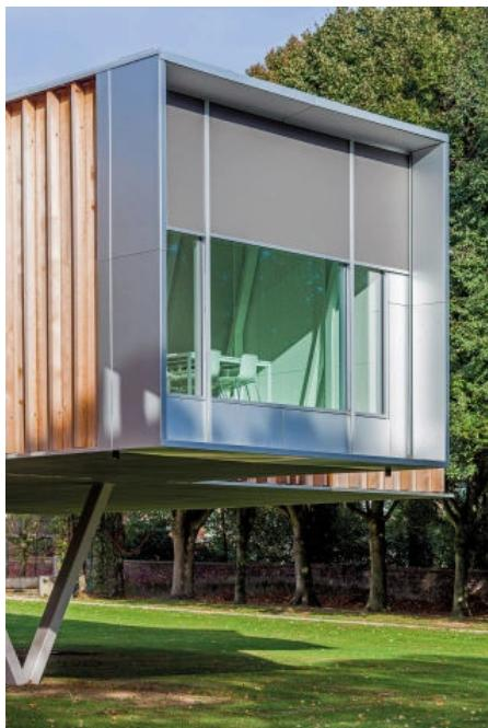
Im Außenbereich angewendete textile Sonnenschutzgewebe bieten einen optimalen Blend- und Wärmeschutz, mit gleichzeitiger Gewährleistung der Sicht nach außen.
