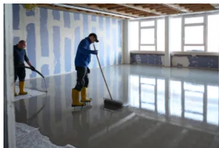
Alle Spachtelmassen der PCI Periplan-Familie sind auch maschinell mit Förderpumpe verarbeitbar
