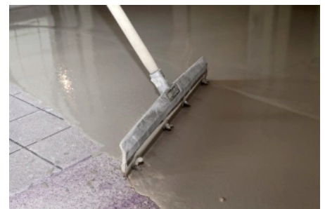
Mit einem Stift- oder Kufenraker lassen sich die Spachtelmassen der PCI Periplan-Familie angenehm im Stehen verarbeiten
