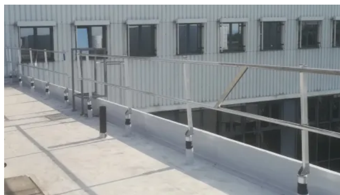
Einbaubeispiel LUX-top® G-T DIREKT WD II
