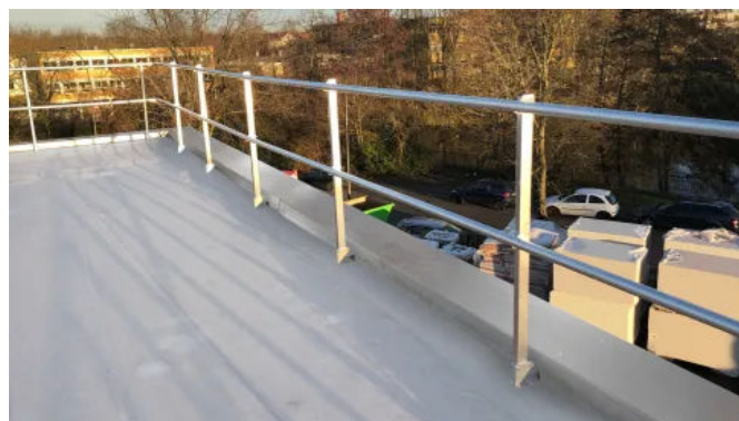
Einbaubeispiel LUX-top® G-T DIREKT AT für Direktbefestigung
