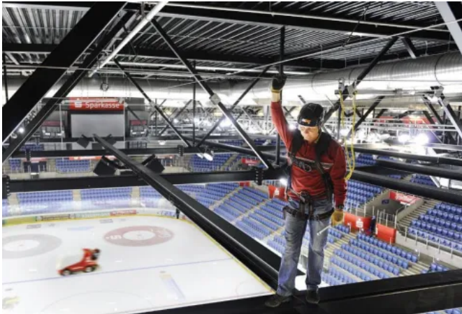
Die Seilsicherungssysteme ABS-Lock SYS kommen in Industrie- oder Veranstaltungshallen, auf Dächern oder an Kranbahnen zum Einsatz.
