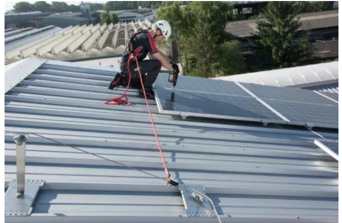
ABS-Lock SYS Seilsicherungssysteme sind optimal, wenn der Arbeitsraum auf Dächern durch PV-Anlagen, Lichtkuppeln oder RWAs eingeschränkt ist.
