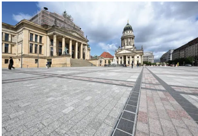
Im Rahmen der Sanierungsmaßnahmen von 2022 bis 2025 wurde die Schwerlast-Schlitzrinne Gemini Magna des ostwestfälischen Metallwarenherstellers auf dem Platz verlegt.
