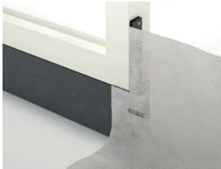
Vor Einschub des Blechwinkels die Nut der Klemmleiste mit geeignetem Dichtstoff füllen
