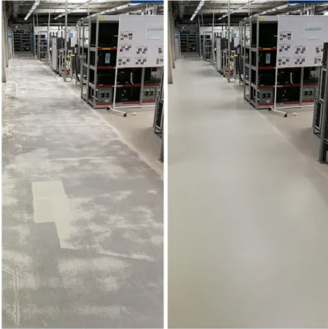
ESD-Boden Sanierung vorher / nachher
