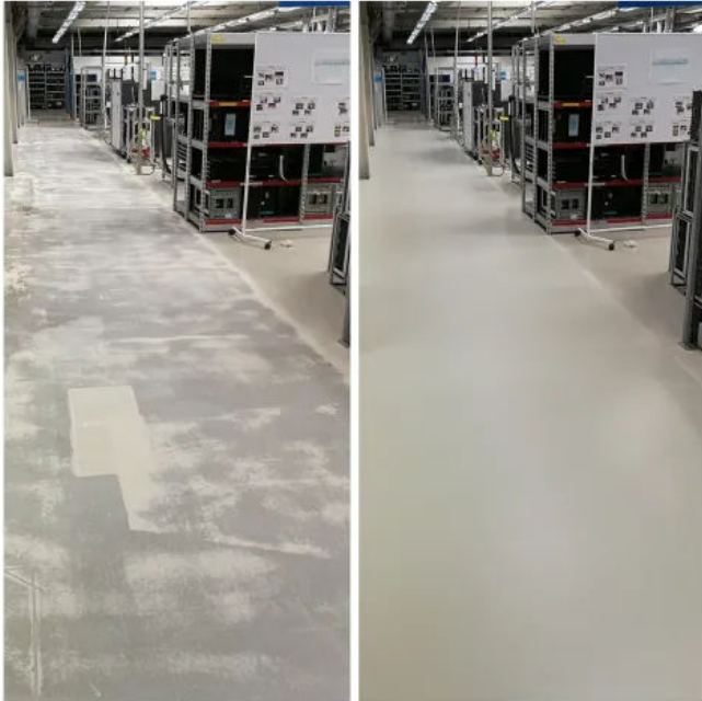
ESD-Boden Sanierung vorher / nachher
