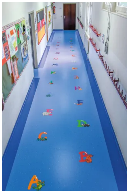
Sanierter und neugestalteter Boden mit Motiven
