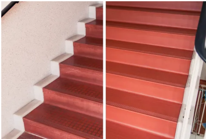
Treppenhaus Haus Emmaus. vorher - nachher
