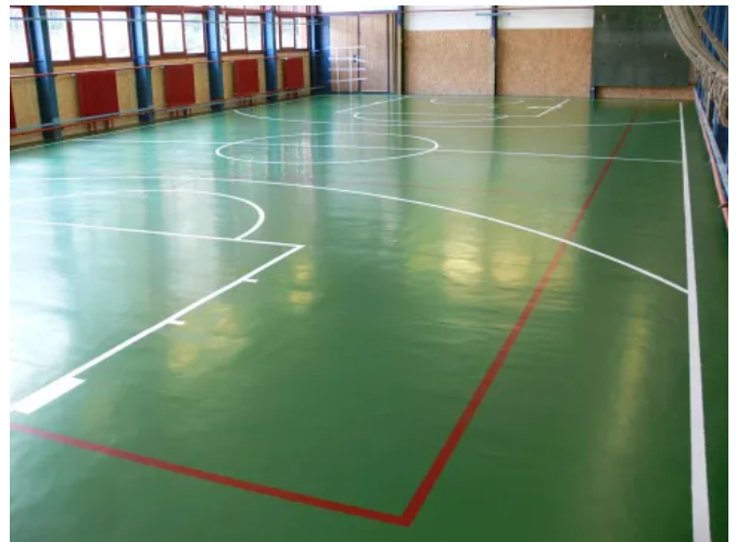
Sporthalle nachher: renovierter Boden
