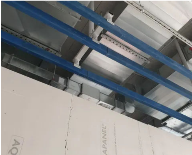
Unterkonstruktion für Abschottungen FA - Traversal
