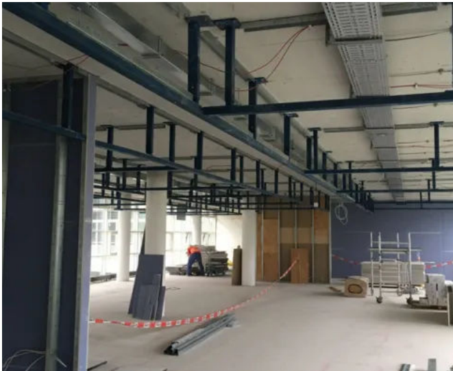
Abschottung FA-DI - Deckenschürzensysteme für Installationen
