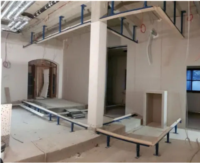
Abschottung FA-B - Teleskoprohr
