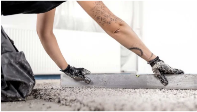
Im UZIN TURBOLIGHT®-SYSTEM kommt ein Leichtausgleichmörtel als schneller Höhenausgleich zum Einsatz.
