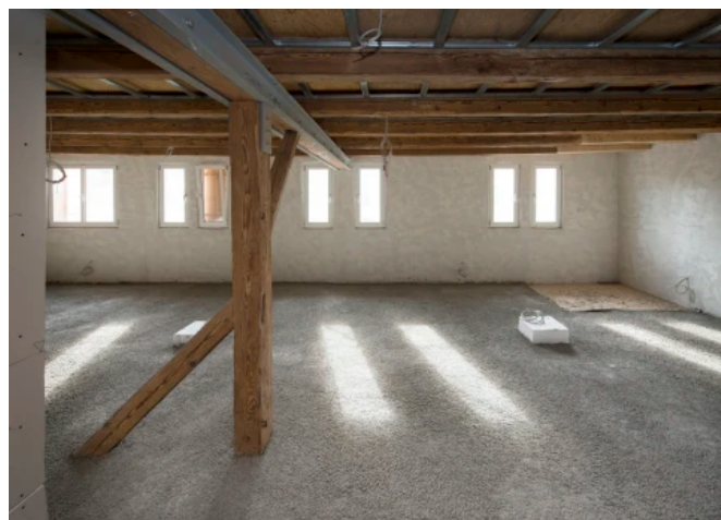
Uzin unterstützte mit dem Leichtestrich Turbolight-System den Bodenaufbau, denn gerade hier zählte der Statiker jedes Gramm Deckenbelastung nach. Weitere Pluspunkte des Systems: geringes Flächengewicht, geringe Aufbauhöhe und schnelle Trocknungszeiten mit schneller Belagreife.
