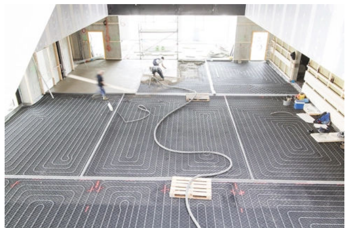
Auf 7.000 m 2 war der Estrich als Heizestrich mit integrierter Fußbodenheizung innerhalb kürzester Zeit und mit perfekter Ebenheit zu verlegen.
