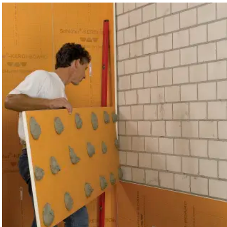
auf Rohbauwänden oder Mischuntergründen
