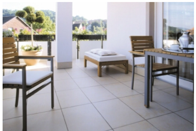
Auch dieser Balkon wurde mit Schlüter®-DITRA saniert.
