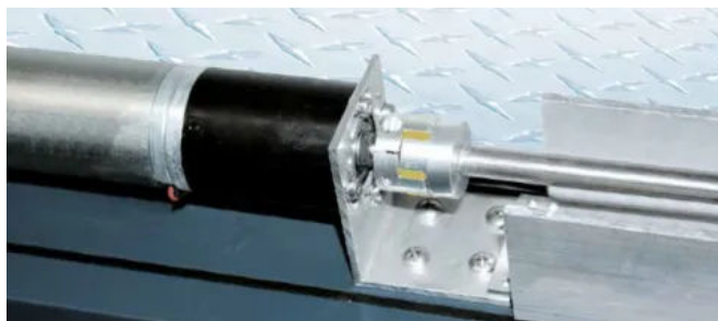
Antriebsmotor Vertikalschiebefenster bei geöffneter Abdeckung
