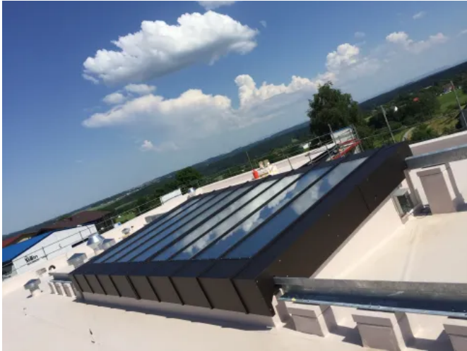
Sonderkonstruktion eines Dachschiebefensters
