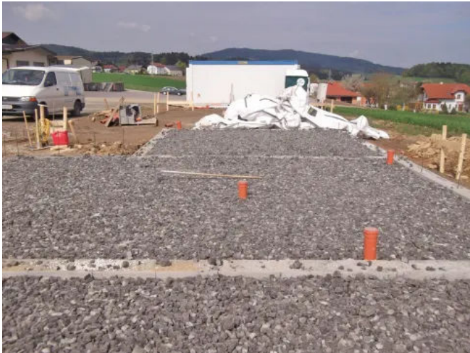
Anwendungsbeispiel Bodenaufbau mit Streifenfundament
