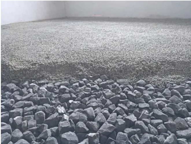
Anwendungsbeispiel Fußbodensanierung, Blähglas zementgebunden
