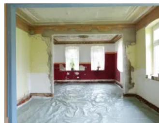
Anwendungsbeispiel Fußbodensanierung mit Estrich, Schritt 3
