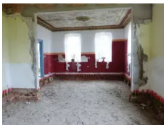
Anwendungsbeispiel Fußbodensanierung mit Estrich, Schritt 1
