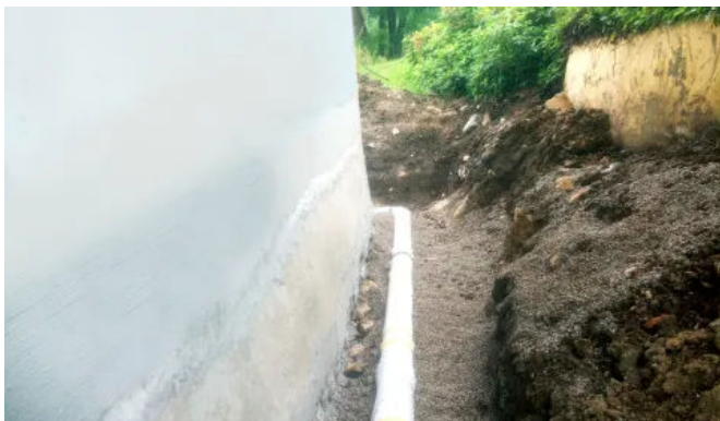
Anwendungsbeispiel Sanierung Vertikale Mauer- und Drainageschüttung
