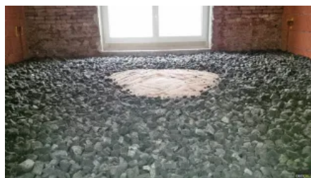
Anwendungsbeispiel Sanierung Gewölbedämmung
