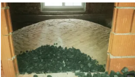
Anwendungsbeispiel Sanierung Gewölbedämmung
