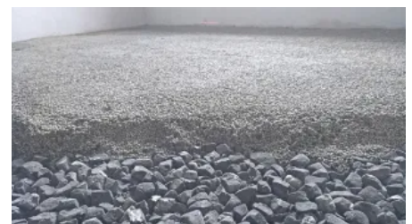
Anwendungsbeispiel Sanierung Gewölbedämmung
