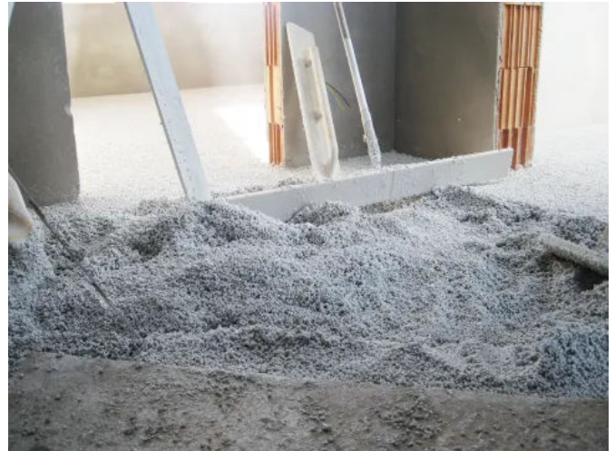
Anwendungsbeispiel Fußbodensanierung, Blähglas mineralisch gebunden
