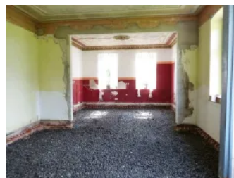
Anwendungsbeispiel Fußbodensanierung mit Estrich, Schritt 2
