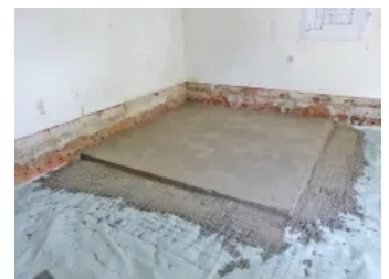
Anwendungsbeispiel Fußbodensanierung mit Estrich, Schritt 4
