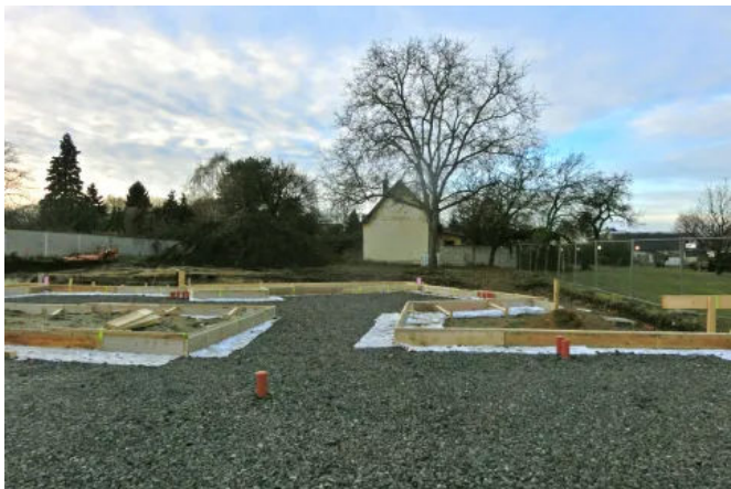
Anwendungsbeispiel Bodenaufbau ohne Streifenfundament
