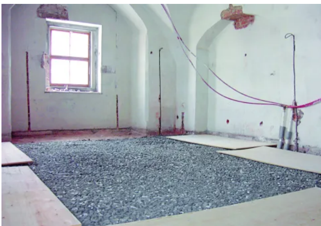
Anwendungsbeispiel Fußbodensanierung ohne Estrich
