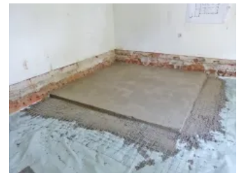
Anwendungsbeispiel Fußbodensanierung mit Estrich, Schritt 4
