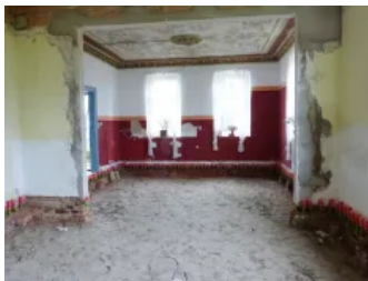
Anwendungsbeispiel Fußbodensanierung mit Estrich, Schritt 1
