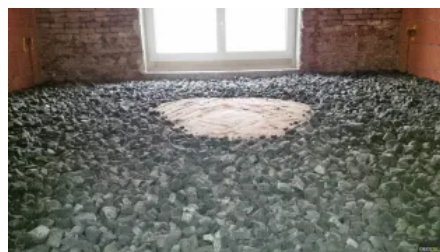
Anwendungsbeispiel Sanierung Gewölbedämmung
