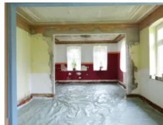
Anwendungsbeispiel Fußbodensanierung mit Estrich, Schritt 3
