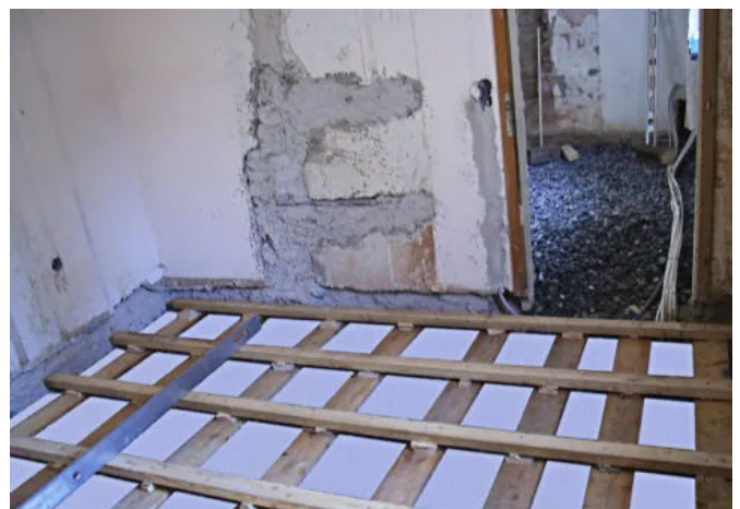
Anwendungsbeispiel Fußbodensanierung ohne Estrich
