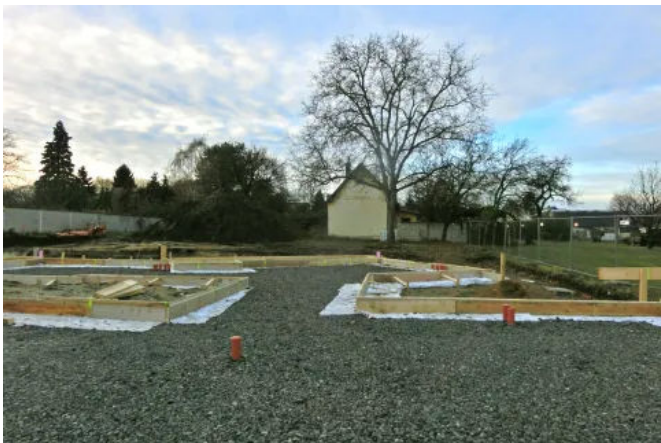
Anwendungsbeispiel Bodenaufbau ohne Streifenfundament
