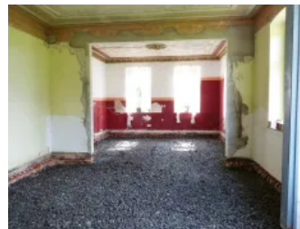
Anwendungsbeispiel Fußbodensanierung mit Estrich, Schritt 2
