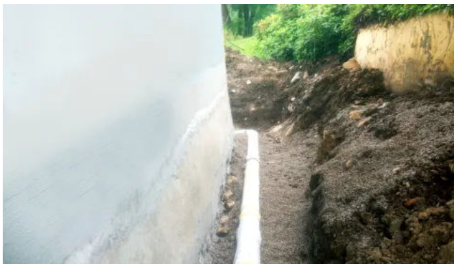
Anwendungsbeispiel Sanierung Vertikale Mauer- und Drainageschüttung
