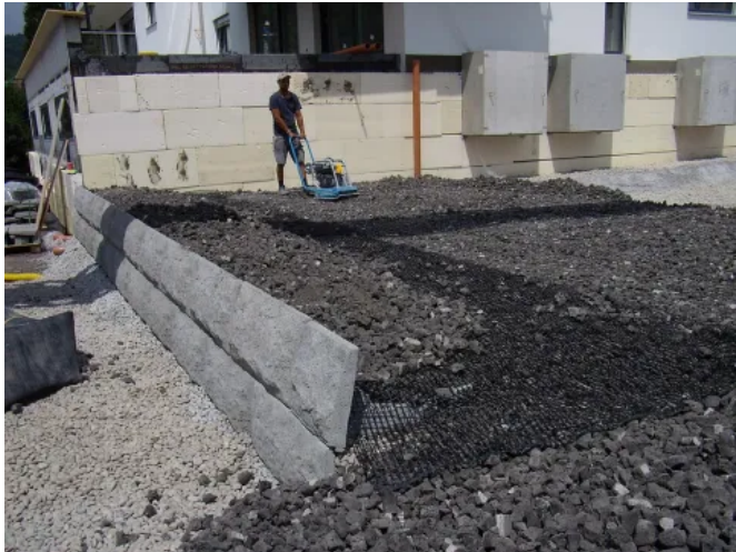
Anwendungsbeispiel Hangsicherung
