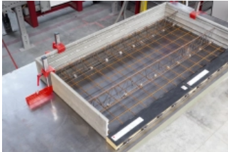
Aufkantung aus Faserbeton
