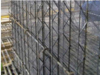
Stremaform® Fugenabstellung
