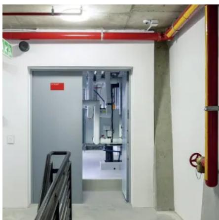
Die Schallschutztür dw 67-1/2 HS ist geprüft nach DIN EN 10140/717 und ein- oder zweiflügelig erhältlich.
