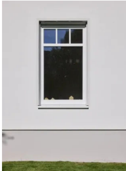
Verschmutzungsunempfindliche Fassade mit Secolux 918: Die Kombination aus drei verschiedenen Nuancen betont die Tiefe der Gebäudehülle und hebt Details wie die Fensterfaschen subtil hervor
