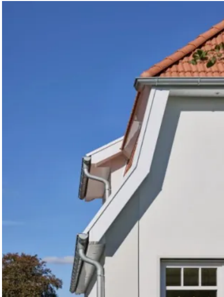
Mit dem WDVS Qju wurde die unebene Fassade historischen Vila ausgeglichen
