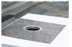
Die flexiblen Lippendichtungen sorgen für festen Halt und gleichen Unebenheiten im Altablauf aus. Gleichzeitig gewährleisten sie die erforderliche Rückstausicherheit.
