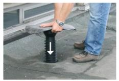
Der alte Dachablauf bleibt, der neue Sanierungsablauf wird einfach hindurchgesteckt, bis zum Stutzen des alten Ablaufs.
