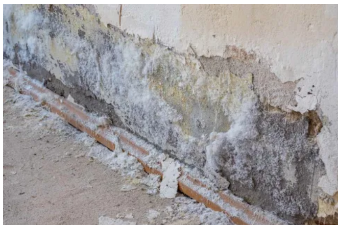
Die Untergrundvorbereitung und Behandlung bauschädlicher Salze bildet die Grundlage für eine nachhaltig funktionierenden Sanierung.
