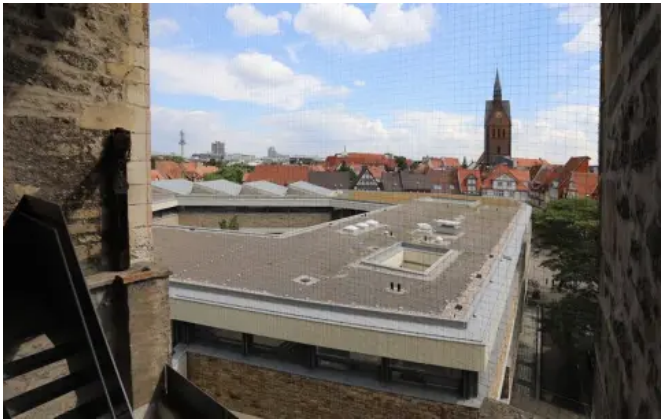
Die einbetonierten Altgullys konnten nicht entnommen werden, sondern mussten saniert werden.
