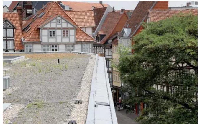
Die Attikaentwässerung verläuft aufgrund des Denkmalschutzes "unsichtbar".
