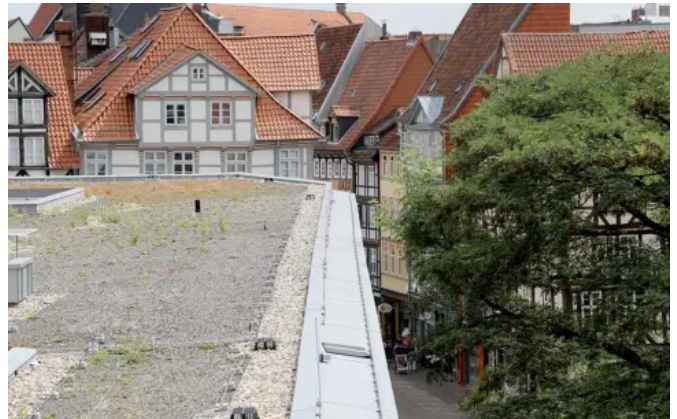
Die Attikaentwässerung verläuft aufgrund des Denkmalschutzes "unsichtbar".
