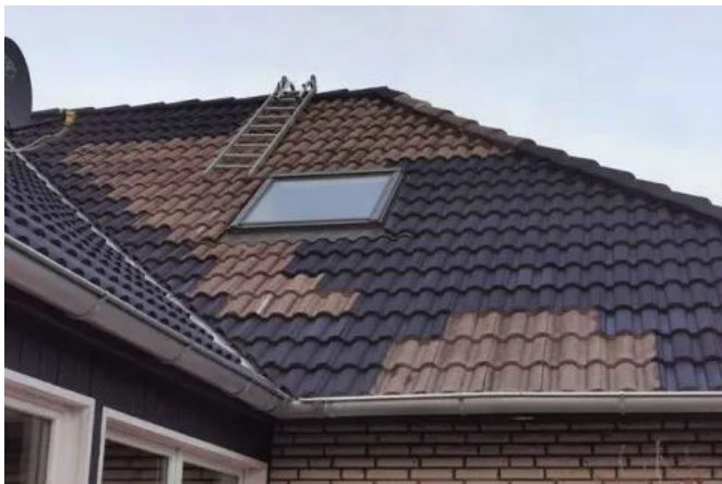
Überarbeitungsanstrich mit Color PA Roof
