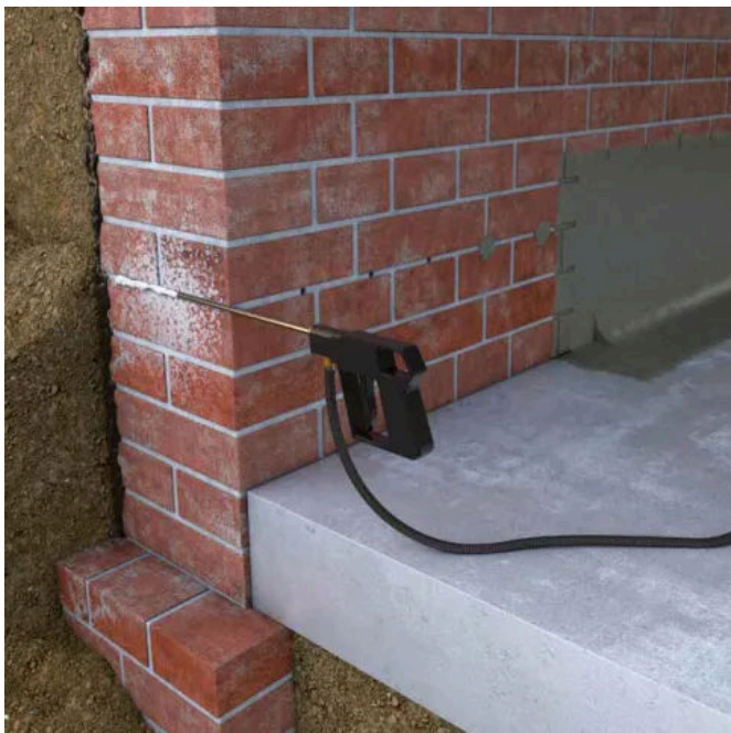
Das creme-Verfahren ohne Hohlraumverfüllung (© Remmers)
