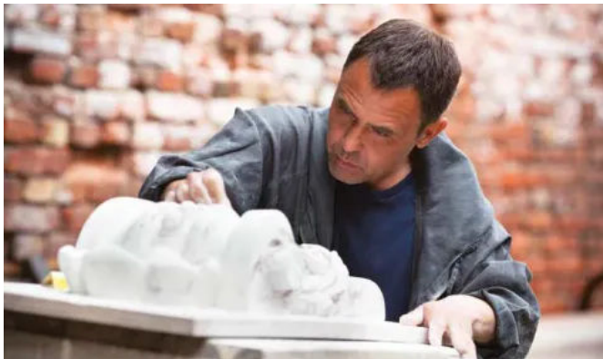
Stuckerneuerung und -reparatur (© Remmers)
