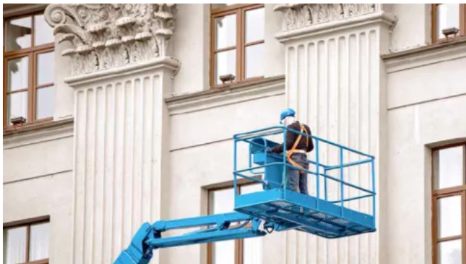
Alte Putzflächen renovieren (© Remmers)
