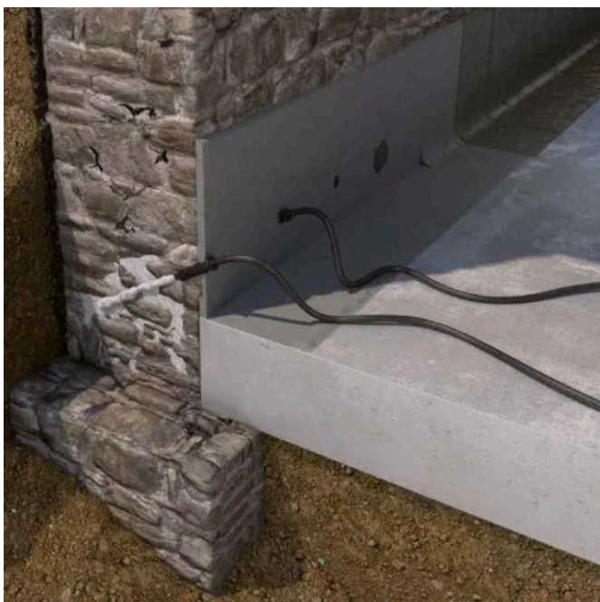
Das advanced-Verfahren mit Hohlraumverfüllung (© Remmers)
