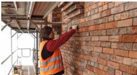
Restauriermörtel-System als Alternative zum Steinersatz (© Remmers)
