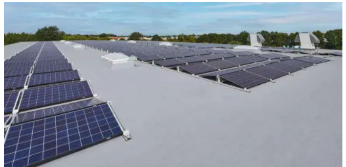
Regeneration der Dachhaut im Zuge baulicher Veränderungen
