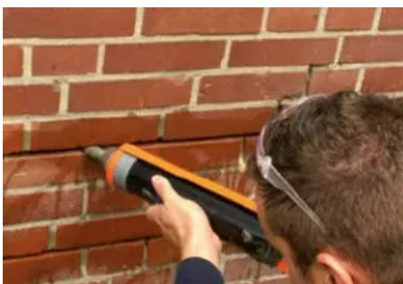
Rissinstandsetzung mit dem Remmers Spezialanker-System (© Remmers)
