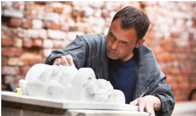
Stuckerneuerung und -reparatur (© Remmers)
