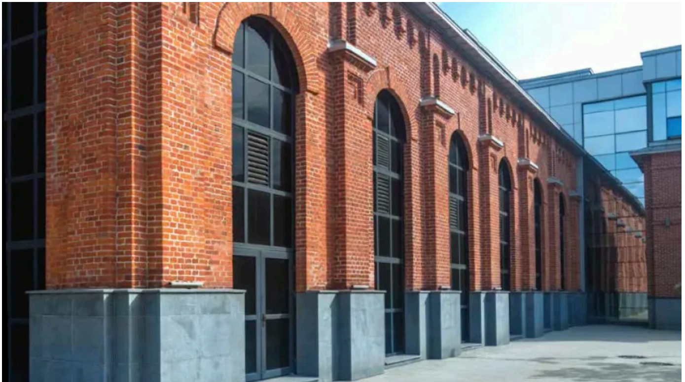
Remmers Ziegelschlämmverfugung (© Remmers)
