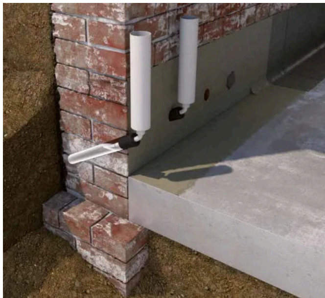
Das classic-Verfahren mit Bohrlochverschluss (© Remmers)
