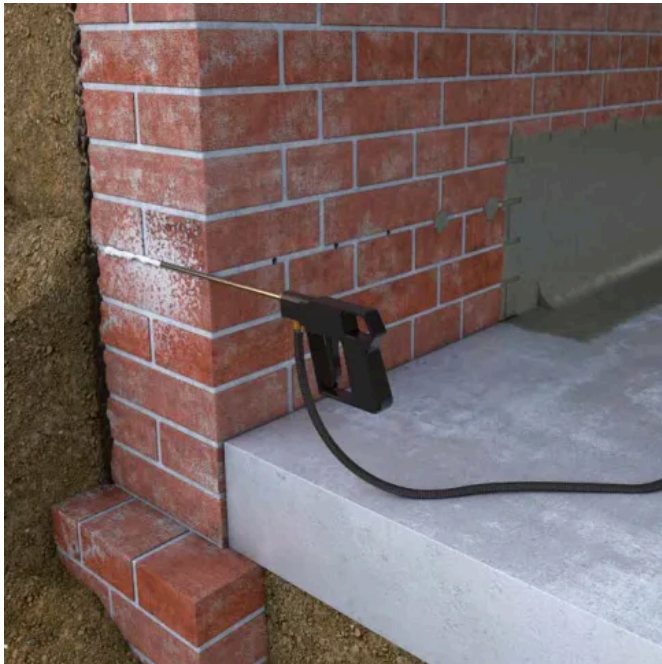
Das creme-Verfahren ohne Hohlraumverfüllung (© Remmers)
