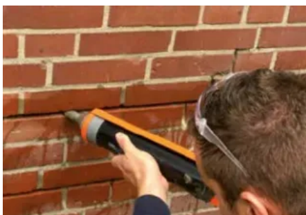
Rissinstandsetzung mit dem Remmers Spezialanker-System (© Remmers)
