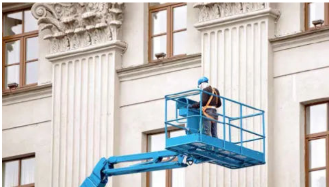
Alte Putzflächen renovieren (© Remmers)
