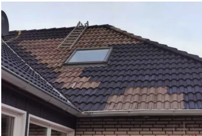
Überarbeitungsanstrich mit Color PA Roof
