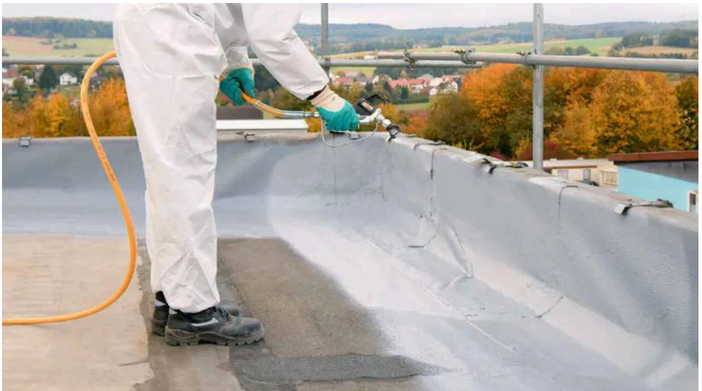
MB PUReactive+ lässt sich auch mit Spritztechnik gut verarbeiten
