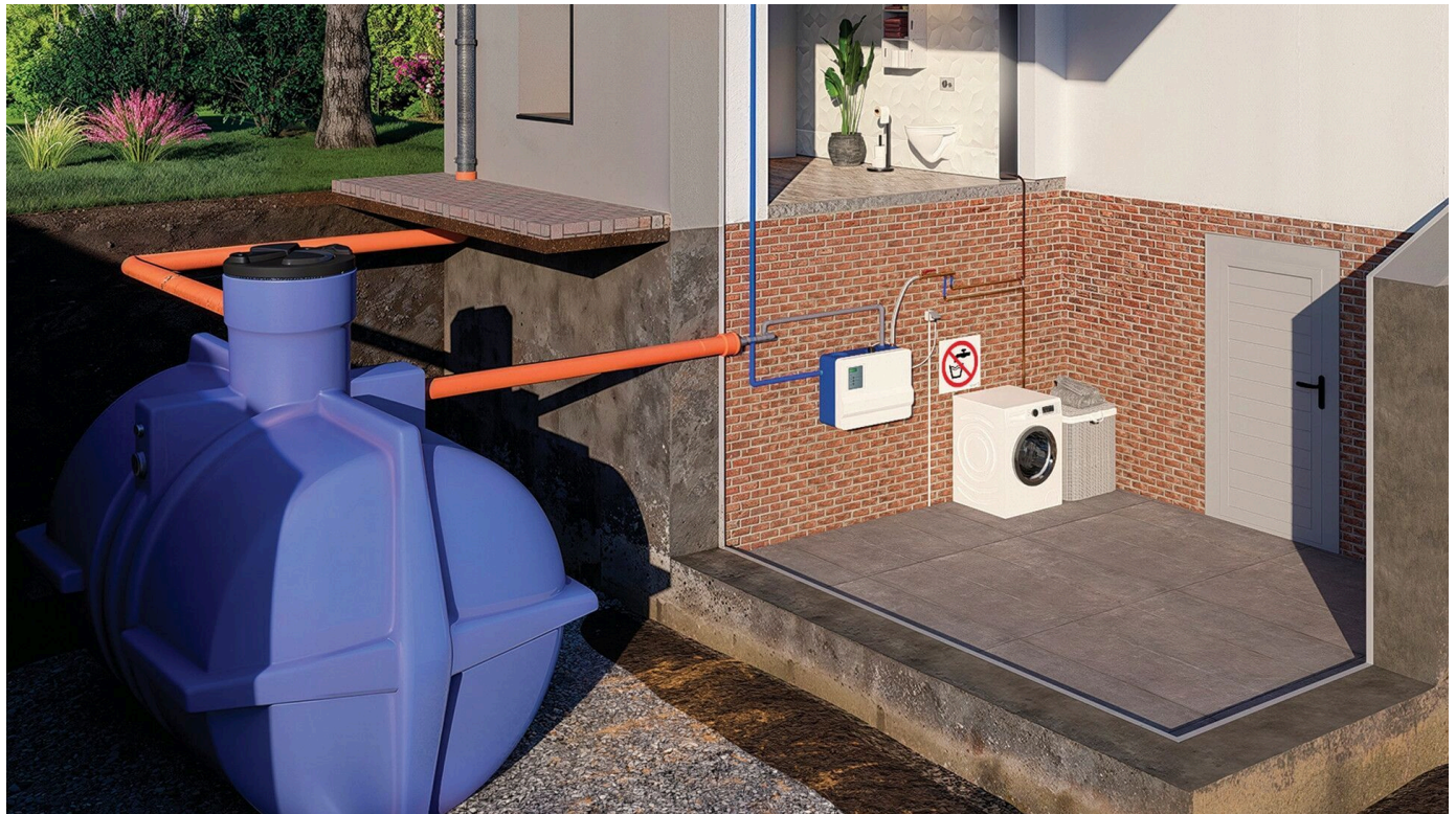
Sanirain-Anlagen zur automatischen Steuerung und Wasserversorgung • Saniboost Hauswasserwerke für stabile Wasserversorgung
