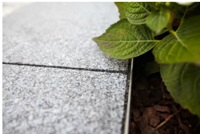
Der SAKRET-Systemaufbausorgt dafür, dass die Platten auf Dauer schön bleiben, sich durch thermische Ausdehnung kaum verschieben und pflegeleicht sind. (© Michael Bader Leipzig)
