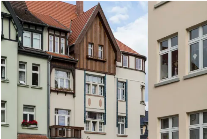
Die denkmalgeschützte Villa in Eisenach wurde originalgetreu mit Putzsystemen des Werk trockenmörtelherstellers SAKRET saniert. (© Michael Bader Leipzig)
