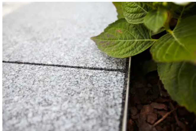
Der SAKRET-Systemaufbausorgt dafür, dass die Platten auf Dauer schön bleiben, sich durch thermische Ausdehnung kaum verschieben und pflegeleicht sind. (© Michael Bader Leipzig)
