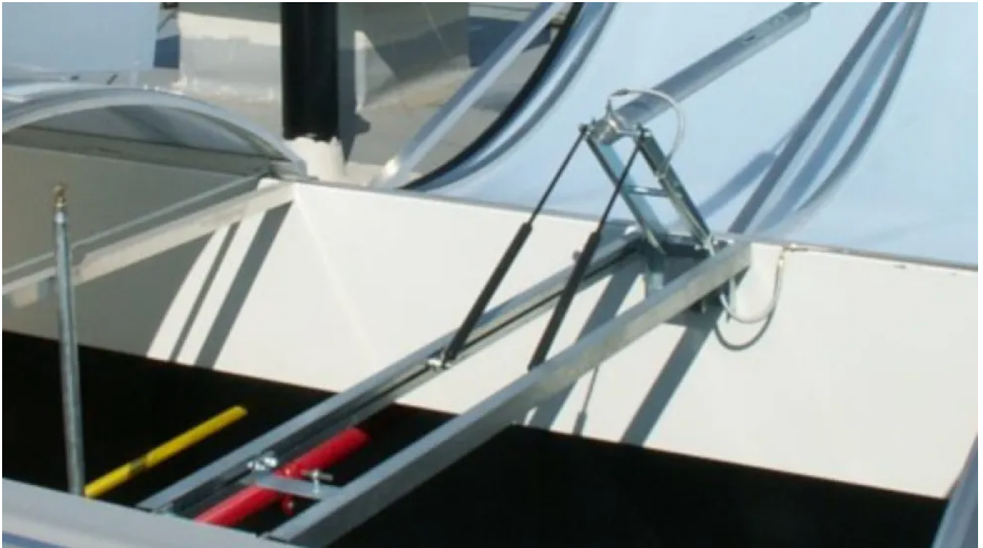
Pneumatische RWA-Komponenten für Lichtbänder
