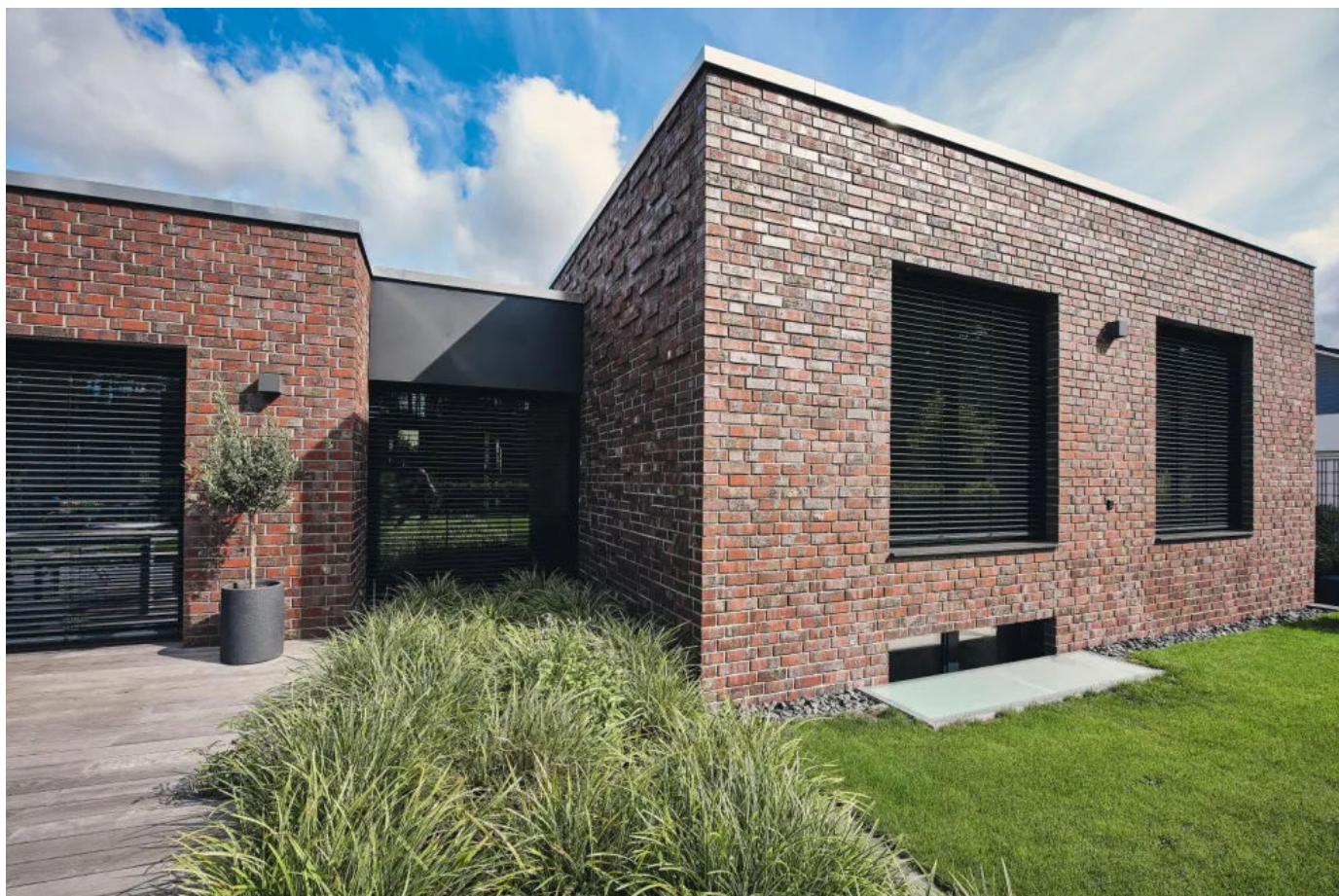
Privathaus in Celle | Klinkerfassade mit Aufsatzraffstoren
