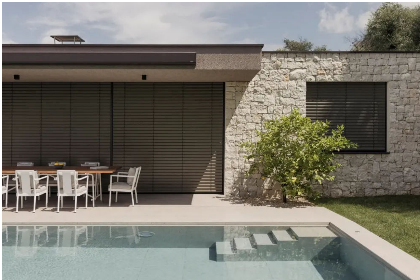
Haus am Gardasee | effektiver Sonnenschutz mit Raffstoren HIGH
