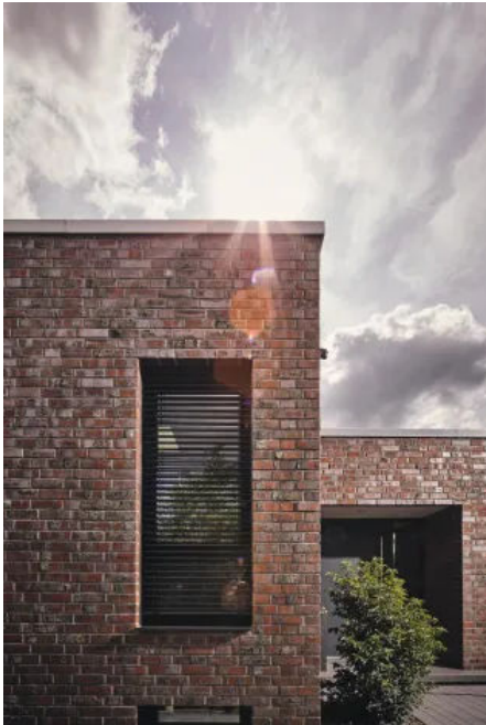
Privathaus in Celle | Klinkerfassade mit Aufsatzraffstoren
