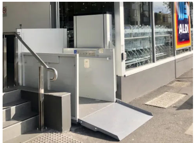
Der Multilift wird standardmäßig in Telegrau mit automatischer Auffahrrampe geliefert. Sein Antriebssystem ist platzsparend im Turm integriert.
