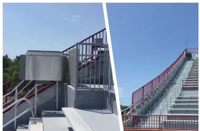
Der witterungsbeständige Artira Außen überwindet Treppen und Podeste barrierefrei über eine Länge von 60 Metern.
