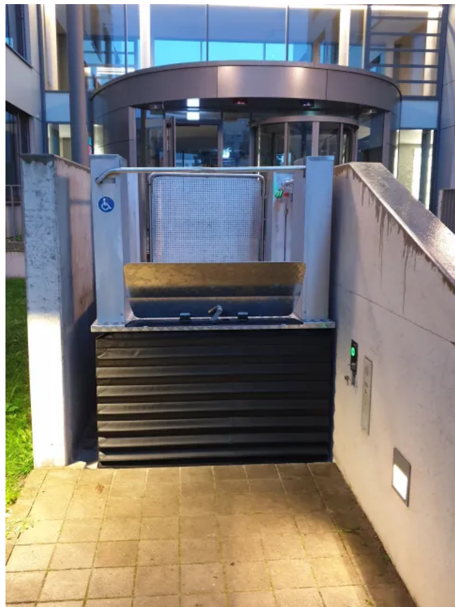
Die Antriebssäulen des MB Quattro erzielen eine Tragkraft von 500 kg.
