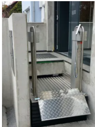
Standardbedienung über Handbedienteil mit Auf-/Ab-Taster.
