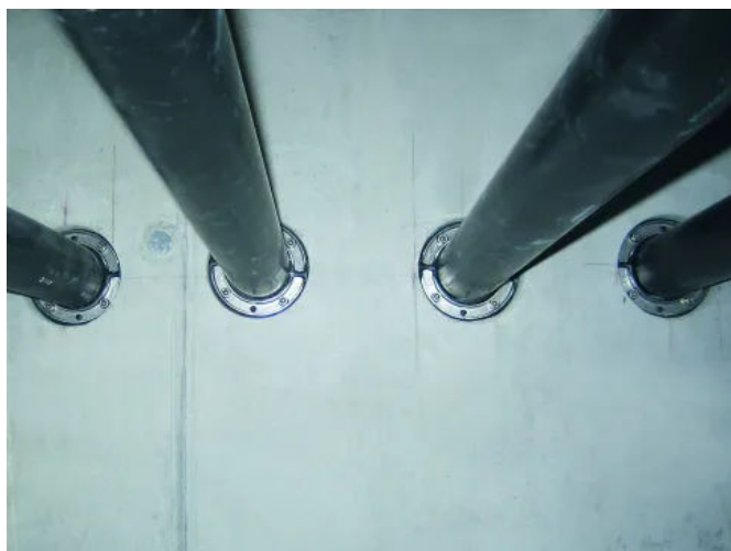
Die Standard-Ringraumdichtung zur Abdichtung von neu zu installierenden oder bereits verlegten Rohren in Kernbohrungen oder Futterrohren ist in allen gängigen Rohrgrößen verfügbar..
