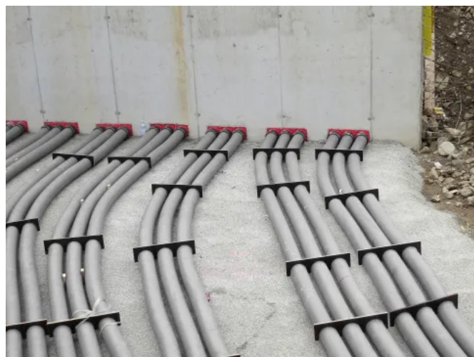
Hateflex Spiralschläuche überzeugen durch Stabilität und Flexibilität. Dank ihrer hohen Scheiteldruckfestigkeit lassen sich überbaubare Leerrohrsysteme realisieren.
