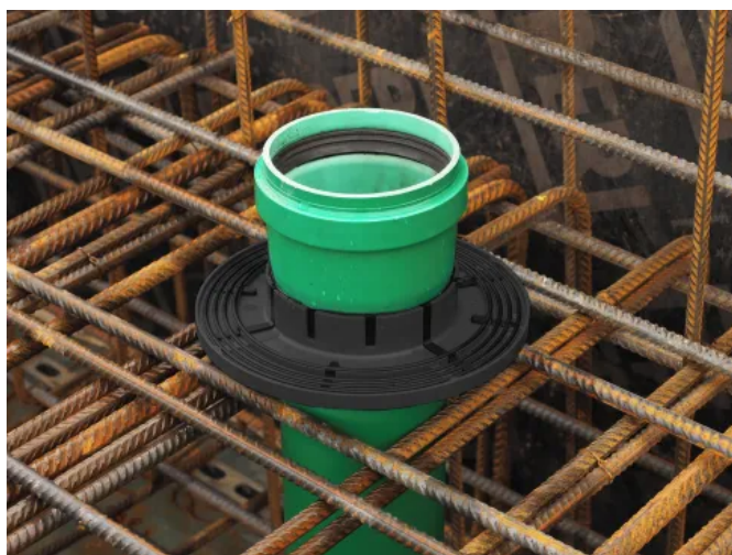
Mauerkragen KG-FIX vor dem Betonieren der Bodenplatte
