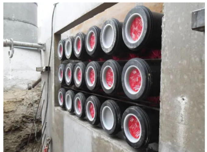
Zur Abdichtung glatter Kabelschutzrohre werden Einfach-Dichtpackung mit Gummisteckmuffe HSI150 GSM Varia eingesetzt.
