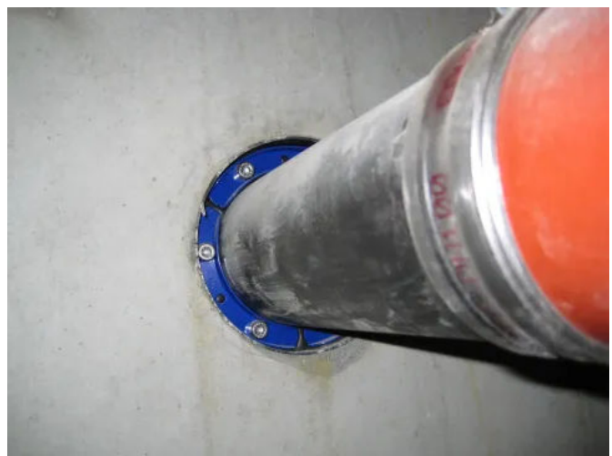
Bei Einsatz von galvanisch verzinkten Futterrohren wird die Standard-Ringraumdichtung mit Pulverbeschichtung empfohlen.
