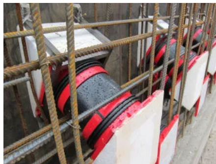
Für schräg geführte Kabeldurchgänge wird die Schrägdichtpackung in Einfach- oder Doppelausführung eingesetzt.
