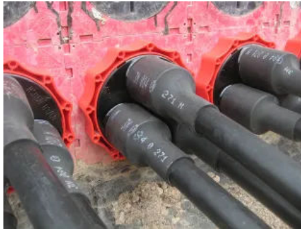
Systemdeckel HSI150 D KS für Kabelabdichtung in Kaltschrumpftechnik.
