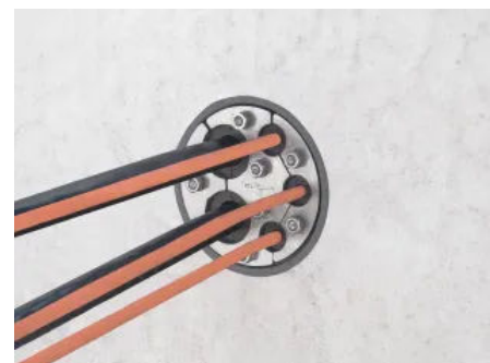
Standard-Ringraumdichtung HRD mit Segmentringtechnik
