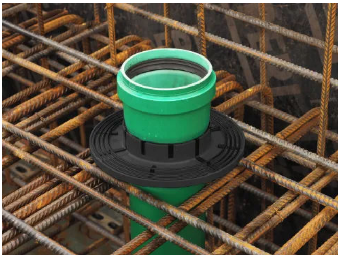
Mauerkragen KG-FIX vor dem Betonieren der Bodenplatte
