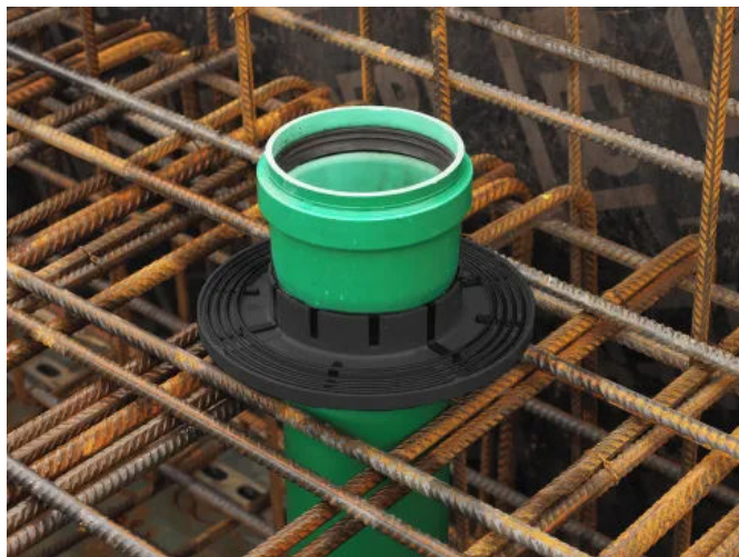
Mauerkragen KG-FIX vor dem Betonieren der Bodenplatte
