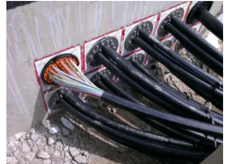
Eine schonende Abdichtung von Steuerleitungen oder Mikrokabeln kann durch Segmenteinsätzen realisiert werden.
