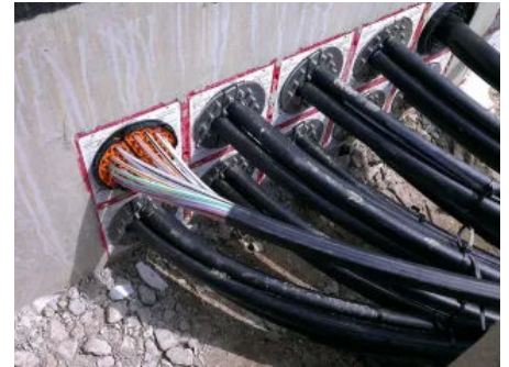
Eine schonende Abdichtung von Steuerleitungen oder Mikrokabeln kann durch Segmenteinsätze realisiert werden.
