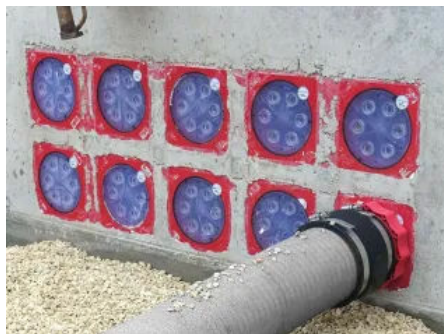
Die Dichtpackungen werden schalungsbündig und druckdicht in den Beton eingebaut.
