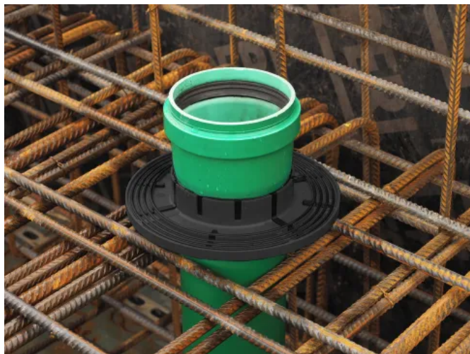
Mauerkragen KG-FIX vor dem Betonieren der Bodenplatte
