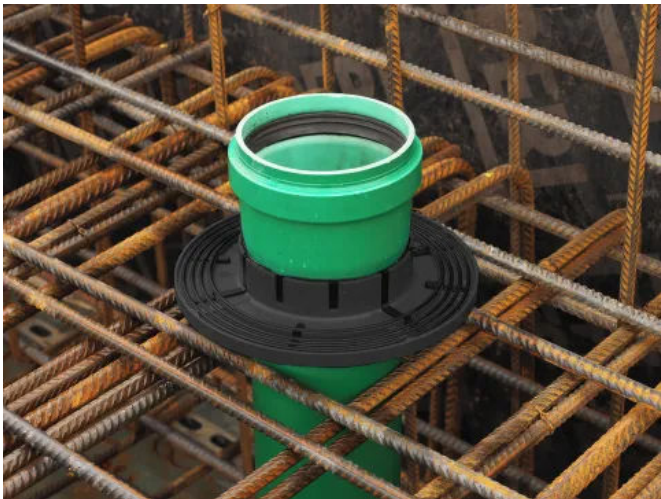
Mauerkragen KG-FIX vor dem Betonieren der Bodenplatte
