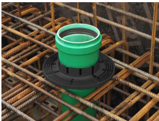
Mauerkragen KG-FIX vor dem Betonieren der Bodenplatte
