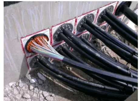
Eine schonende Abdichtung von Steuerleitungen oder Mikrokabeln kann durch Segmenteinsätzen realisiert werden.
