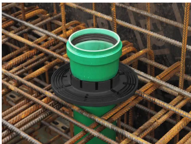
Mauerkragen KG-FIX vor dem Betonieren der Bodenplatte
