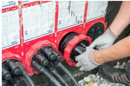
Die Systemdeckel werden vor der Kabelverlegung montiert. Unbelegte Stutzen können für eine spätere Belegung dicht verschlossen werden.
