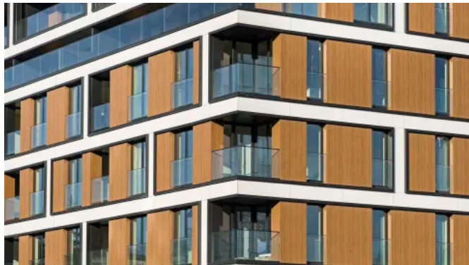
Rockpanel Fassadenplatten sind flexibel und biegsam, um der Form des Gebäudes zu folgen. (© Rafal Chojnacki Fotografia Architektury)
