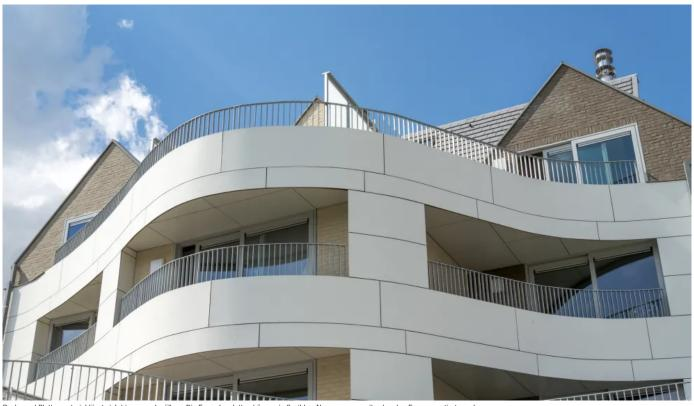
Rockpanel Plattenmaterial lässt sich biegen und wölben. Die Fassadenplatten können in flexiblen Abmessungen mit schmalen Fugen montiert werden.
