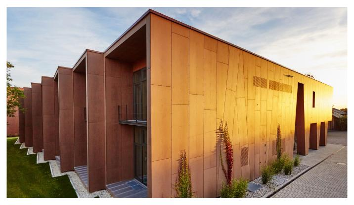
Rockpanel Natural umfasst unbeschichtete Fassadenplatten in purer Puristik, ohne Farbauftrag und ohne Oberflächenversiegelung. Das Aussehen von Rockpanel Natural wird durch das Klima bestimmt. Sonne, Wind und Regen werden zu Mitgestaltern der Fassade.
