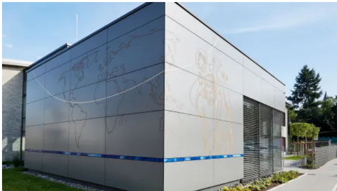
Eine hinterlüfteten Fassade mit Rockpanel A2 Fassadenplatten erhöht die Brandsicherheit des Gebäudes.
