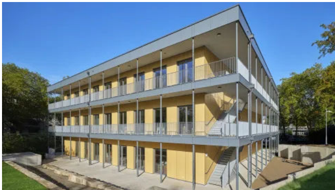
Eine vorgehängte hinterlüftete Fassade mit Rockpanel erlaubt eine freie Gestaltung der Fassade. (© WOLF SCHILY)
