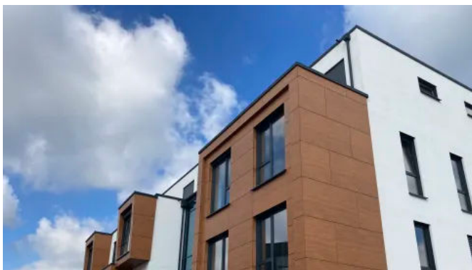
Rockpanel Fassadenplatten lassen sich mit schmalen Fugen montieren.
