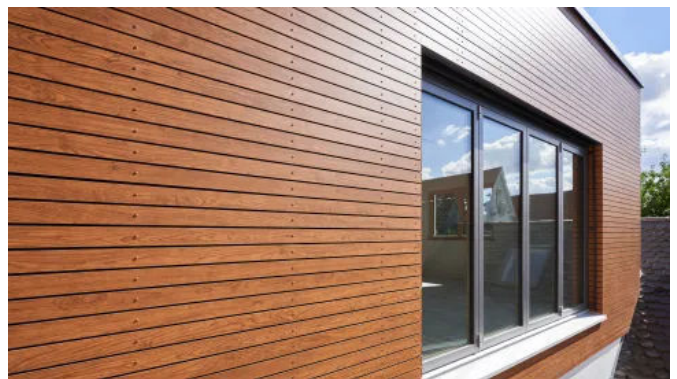
Rockpanel Woods Platten können ähnlich wie Holz verarbeitet werden. (© Foto Behrendt)
