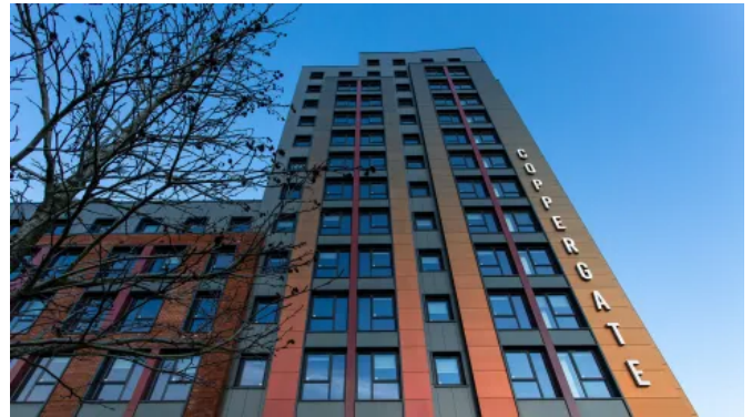
Rockpanel A2 Fassadenplatten sind geeignet, wenn eine hohe Brandsicherheit wünschenswert oder vorgeschrieben ist.
