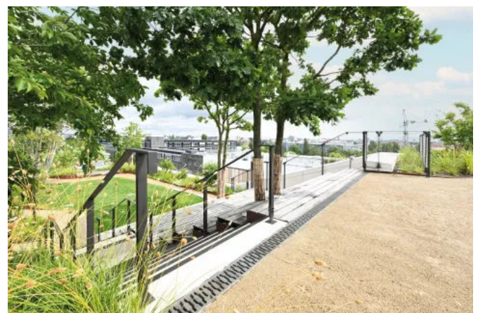
Die 80 mm hohen Rinnen aus Beton unterstreichen in Kombination mit den Gussrosten „Zippa“ auch das Farbkonzept, geprägt durch dunkle Geländer und Streifen entlang der Treppen.
