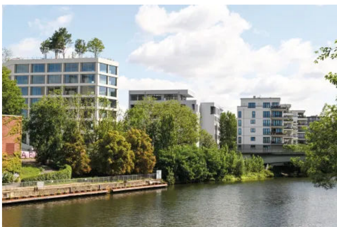
Das Geschäftshaus AERA fügt sich in das urbane Umfeld der umliegenden Gebäude ein, andererseits hebt sich durch den imposanten Dachgarten deutlich ab.
