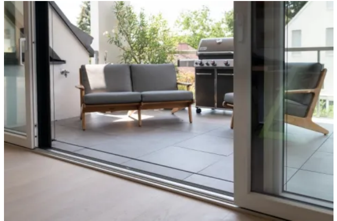
Verflieste Rinne, Privatobjekt
