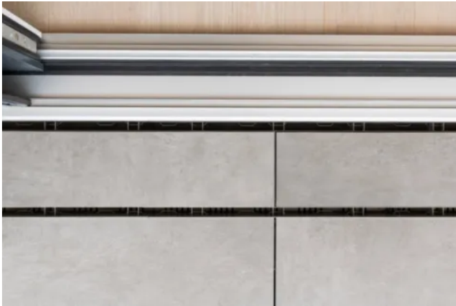
Verflieste Rinne, Privatobjekt
