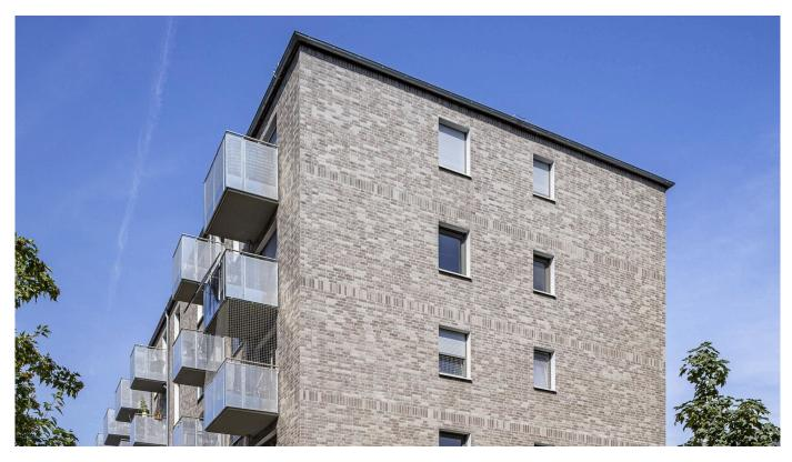
Riemchen besitzen die gleichen technischen Eigenschaften wie Vormauerziegel, sind aber nur maximal 2 cm dick. Sie lassen sich einfach und schnell auf fast allen Untergründen verlegen und sind daher insbesondere für Sanierungen geeignet. Nahezu jeder Fassadenziegel aus dem Sortiment von Vandersanden ist auch als Riemchen erhältlich, sodass im Ergebnis eine identische optische Wirkung erzielt werden kann.
