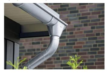
Zur Vermeidung von Außen- oder Kellerwand-Durchfeuchtungen sollte das über das Dach ablaufende Regenwasser über ein Dachentwässerungssystem abgeführt werden. Dieses Dachentwässerungssystem besteht in der Regel aus Dachrinnen und anschließenden Regenfallrohren, die das Regenwasser dann in das öffentliche Entwässerungsnetz einleiten, bzw. einer Regenwassernutzungsanlage oder einer Versickerung durch Rigolen oder Mulden zuführen.
