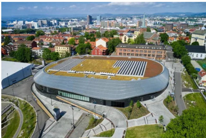
Stadion Nye Jordal Amfi, Oslo, Norwegen | Hille Melbye arkitekter, Oslo, Norwegen
