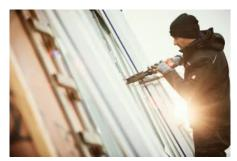
Der neue CLIPFIX 3in1 ist ein leistungsstarkes Multitool für alle Profis, die Stehfalzdeckungen verarbeiten. Der Schrauber kombiniert Magazinbetrieb, Bohrfunktion und Schraubfunktion in einem einzigen Gerät - ein echtes Effizienz-Upgrade für die Baustelle. Neu dabei: die AMPShare-Akkutechnologie, die den Einsatz über viele Werkzeugmarken hinweg möglich macht. Mehr Flexibilität geht nicht.
