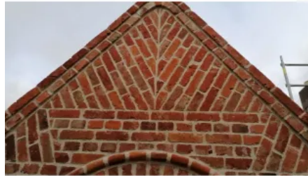
Anwendungsbeispiel: ReUse Ziegelsteine im Denkmalschutz
