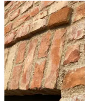
Anwendungsbeispiel: ReUse Ziegelsteine im Denkmalschutz
