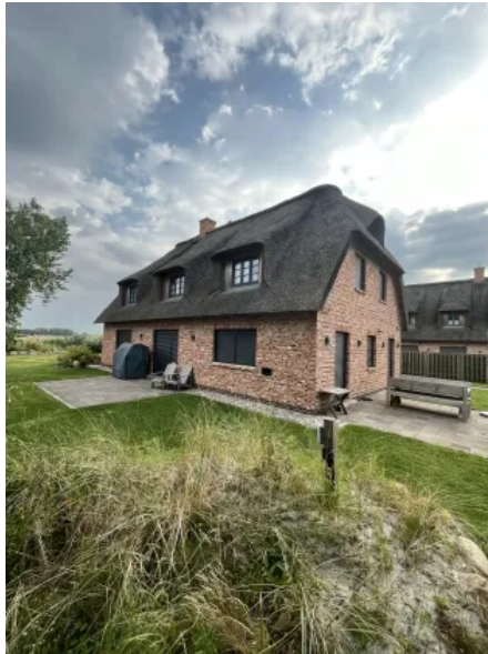
ReUse Ziegel - rot - "Tetenbüll"
