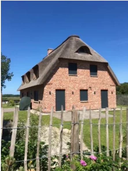
ReUse Ziegel - rot - "Tetenbüll"
