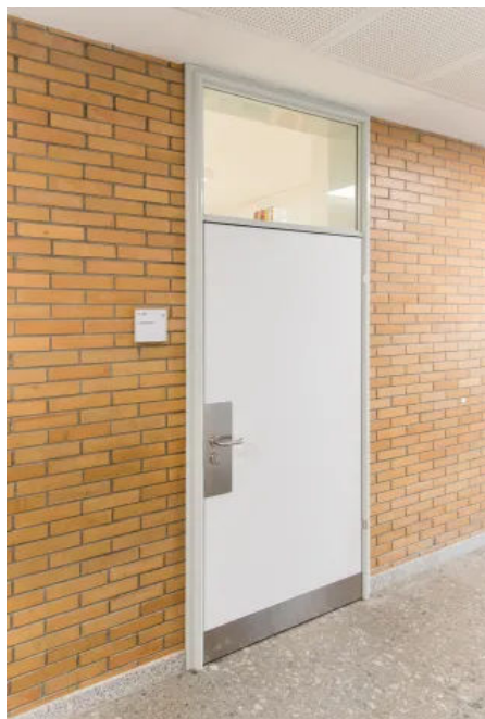
Aloys-Schreiber-Schule in Bühl | zweischalige Renovierungszarge RENOVI
