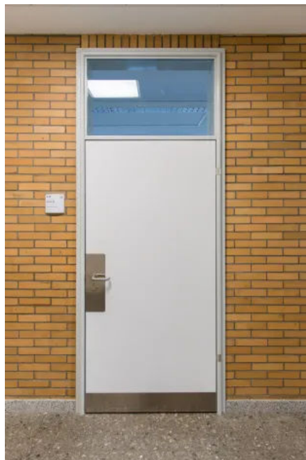
Aloys-Schreiber-Schule in Bühl | zweischalige Renovierungszarge RENOVI
