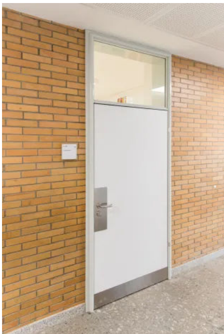
Aloys-Schreiber-Schule in Bühl | zweischalige Renovierungszarge RENOVI
