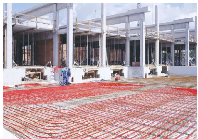
Die REHAU Freiflächenheizung hält Verkehrsflächen schnee- und eisfrei bei Minusgraden.
