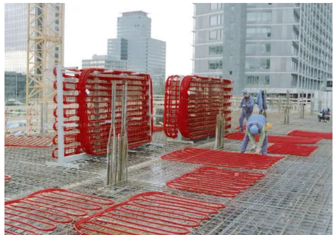
REHAU bietet 3 Systeme zur Betonkerntemperierung: Verlegung vor Ort, vorkonfektionierte Module oder Module für die Verlegung in Betonfertigteilen.
